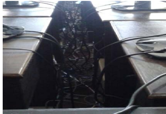
Gambar 3. Instalasi Kabel Jaringan
