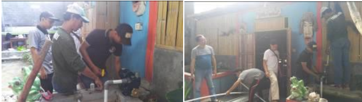
Gambar 3. Pemasangan pompa air dan instalasinya
