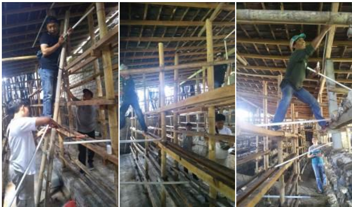
Gambar 4. Pemasangan instalasi air untuk pengaturan suhu dan kelembabam rumah/kubung jamur.
