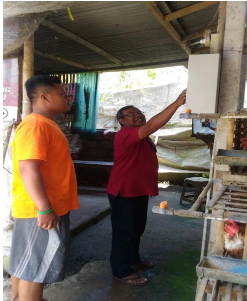
Gambar 5. Pelatihan Mengoperasikan Panel Pompa
