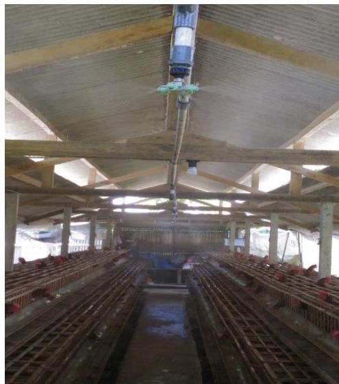
Gambar 6. Penyemprotan Disinfektan Melalui Sistem yang Telah Dipasang
