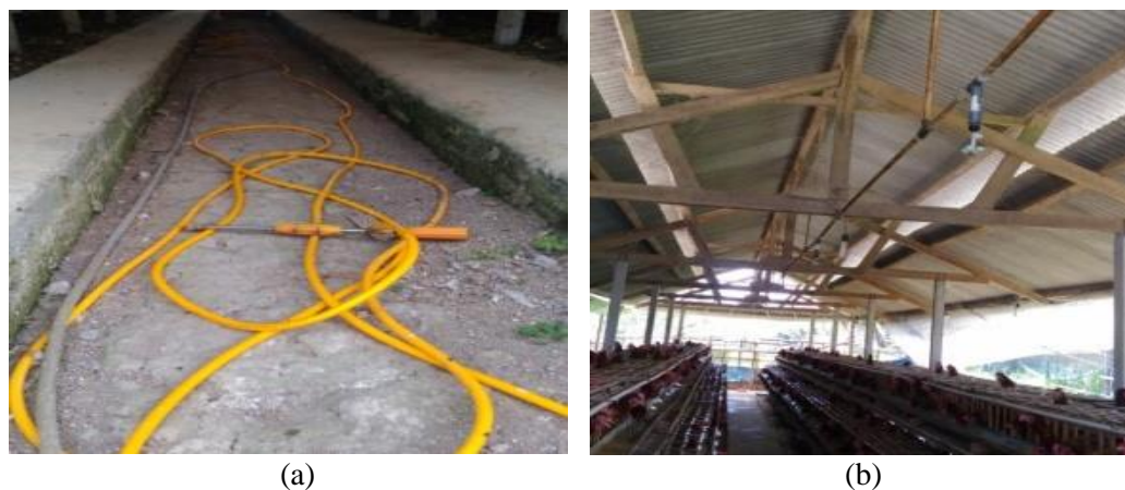
Gambar 2. (a) Sebelum Instalasi Pipa, (b) Sesudah Instalasi Pipa
