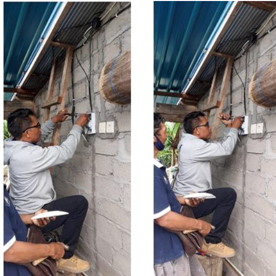
Gambar 2. Proses instalasi sambungan baru meteran listrik PLN
