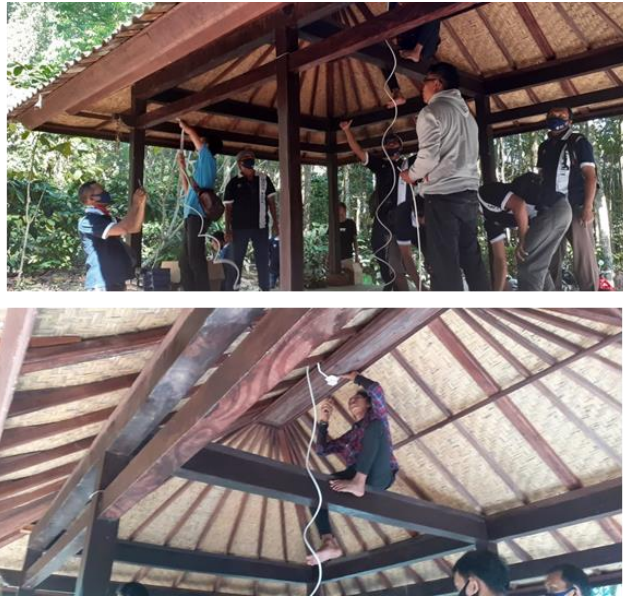
Gambar 4. Proses Instalasi listrik power outlet dan penerangan di bale bengong bawah
