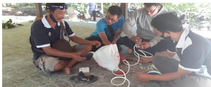
Gambar 3. Proses instalasi listrik untuk power outlet dan penerangan di pura
