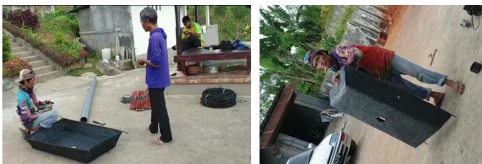
Gambar 8. Pembuatan bak untuk mengumpulkan air di mata air
