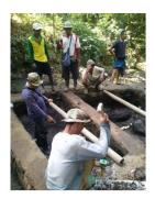
Gambar 4. Pembuatan saringan air dan penutup bak penampungan
