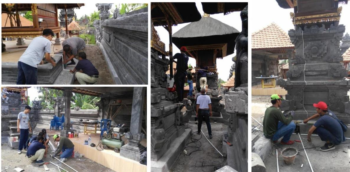
Gambar 1. Pemasangan instalasi listrik, pencahayaan dan air bersih.
