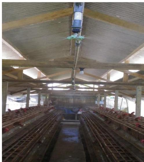
**Gambar 6.** Penyemprotan Disinfektan Melalui Sistem yang Telah Dipasang
