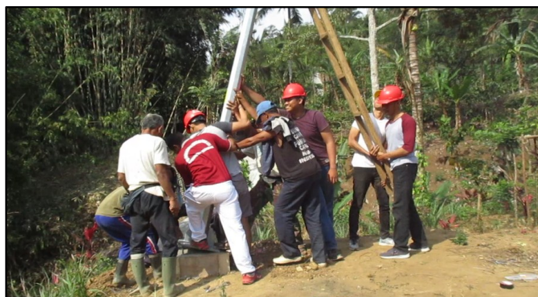
Gambar 4. Pemasangan Lampu Penerangan Jalan Tenaga Surya (LPJ-TS) bersama warga desa Kebonpadangan
