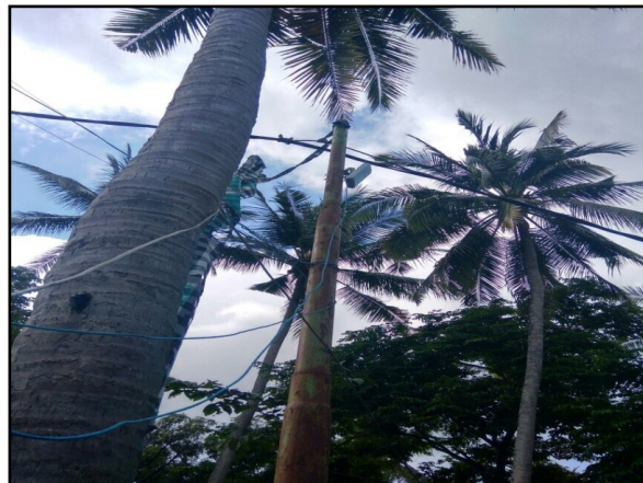
Gambar 5. Instalasi kabel STP
