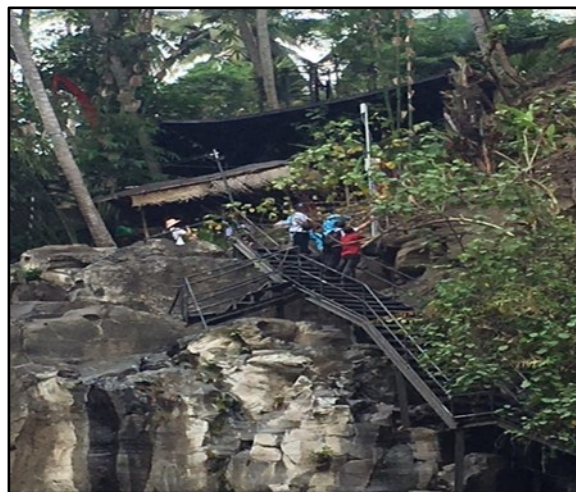
Gambar 2. Kegiatan instalasi jaringan di lokasi Blangsinga Waterfall
