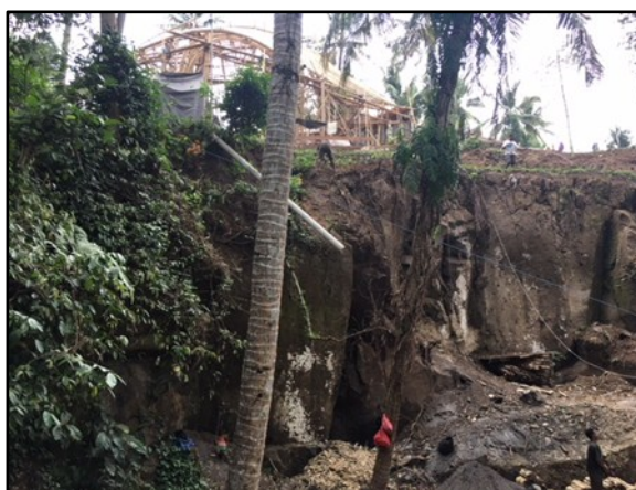
Gambar 3. Lokasi tengah penarikan kabel STP antara jalur masuk atas menuju lokasi bawah
