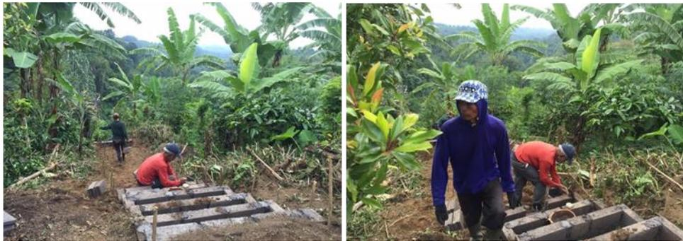
**Gambar 6.** Pembuatan tangga *trekking* ke air terjun
