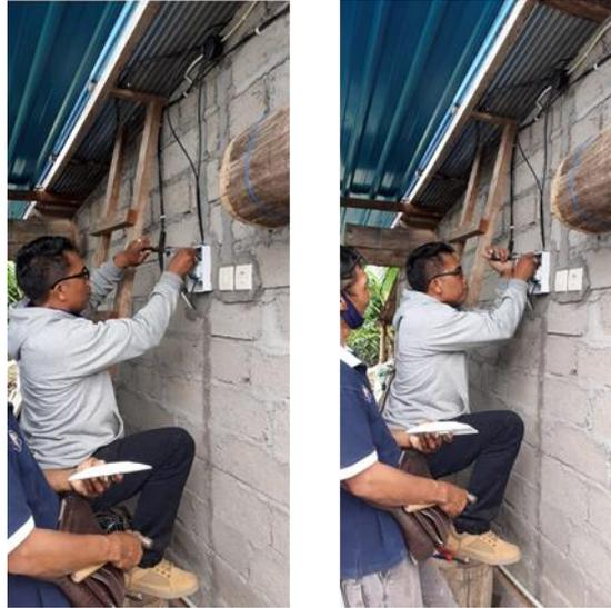
**Gambar 2.** Proses instalasi sambungan baru meteran listrik PLN
