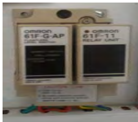
Gambar10 Floatless level switch dan probe
