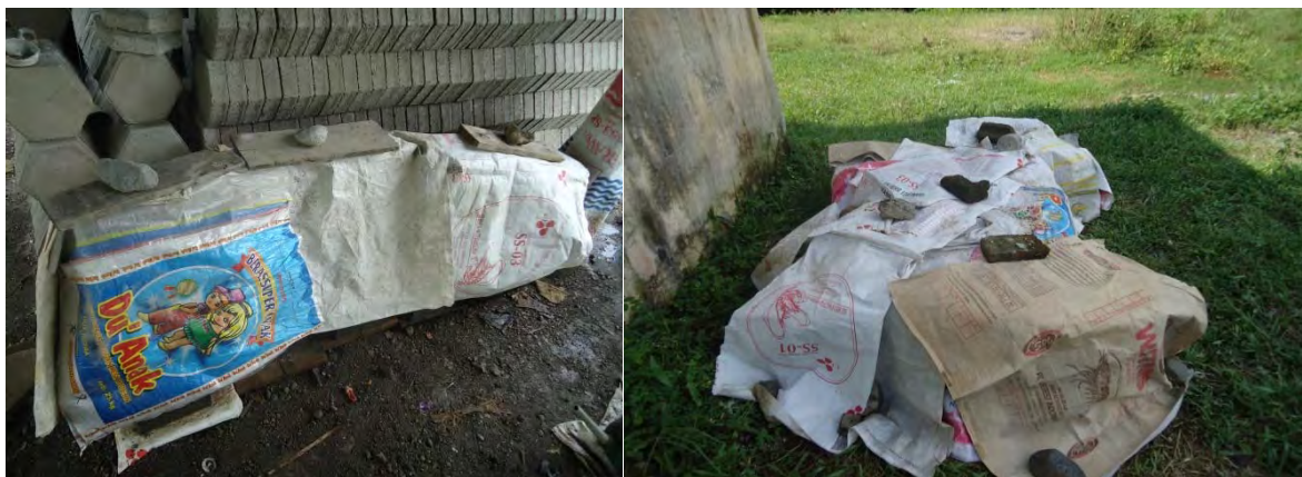
Fig. 3.Curing CPB
